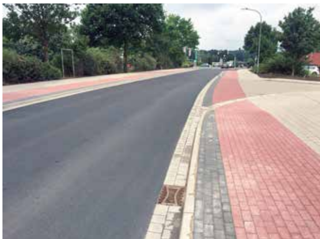
Die beidseitig ausgebauten Geh- und Radwege verlaufen bis zur Kreuzung Waterloostraße/Bremer Straße.
