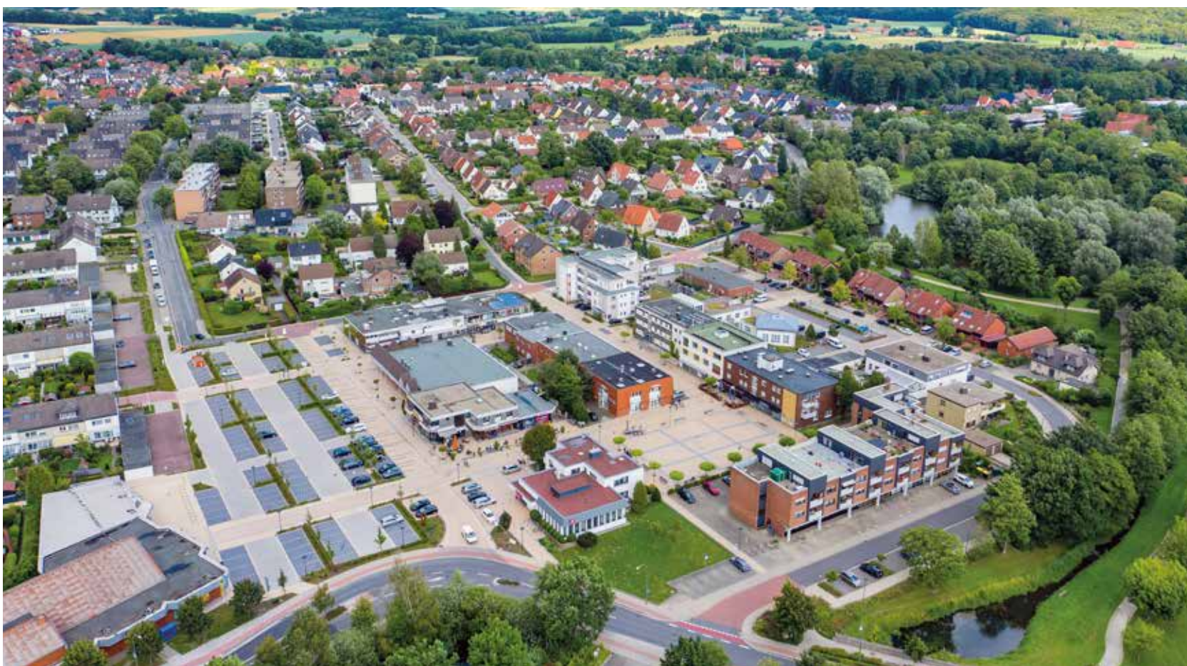
Das Luftbild zeigt den Belmer Marktring nach Abschluss der Baumaßnahme Waterloostraße/Leconskamp.
