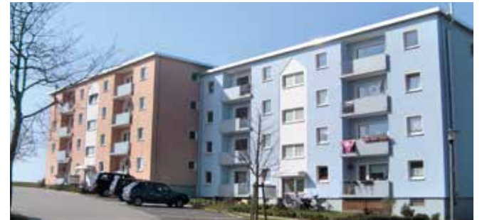
Sanierte Wohnungen „Auf der Gehlke“ in Vehrte. Foto: Birgit Gern
