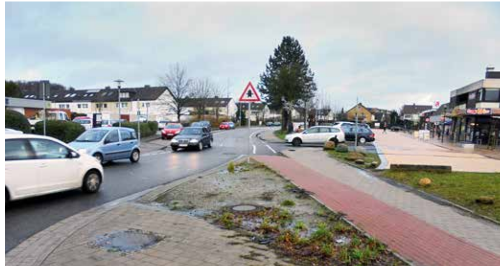
Im Fahrbahnbereich der Ringstraße entstehen weitere Parkplätze.
